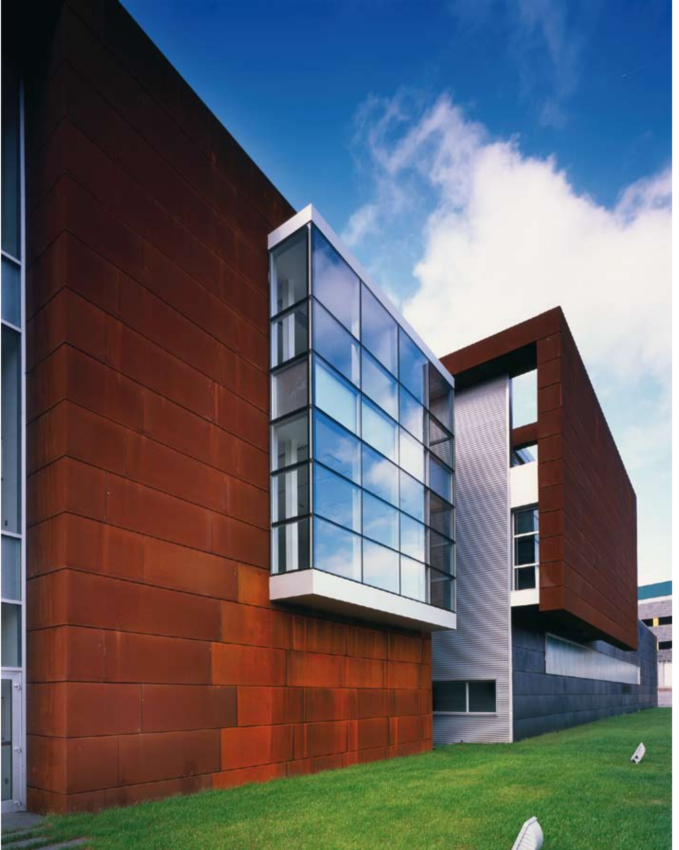
Zentrum für Stahltechnologie.
