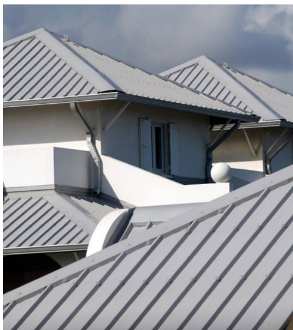
Cubierta de zinc
