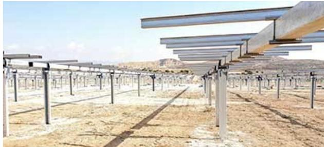
**Figura 1.** Ejemplo de estructura de seguidores fotovoltaicos (fuente: Gonvarri Solar Steel)
