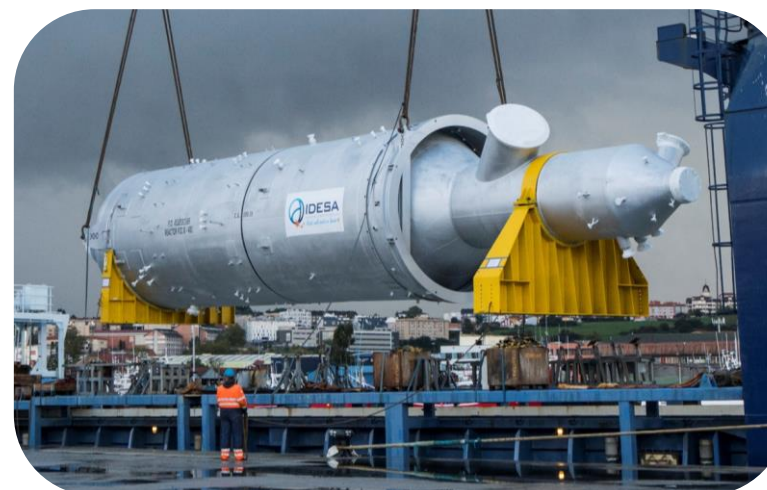
10 EQUIPOS FCCU (~2.850 TON)
