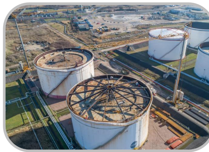
MANTENIMIENTO Y REFORMA DE TANQUES DE ALMACENAMIENTO
