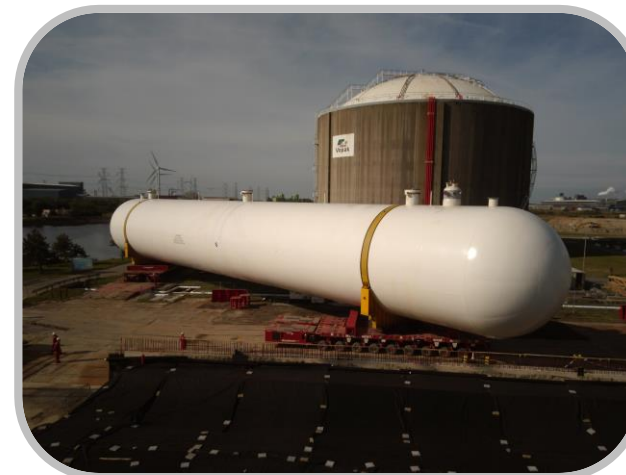
INSTALACIÓN DE EQUIPOS EN CAMPO
