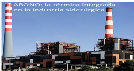
CT Aboño: G1=342 MW y G2=536 MW
