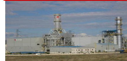
CCGT Castejón: G1=425 MW y G3=418 MW
