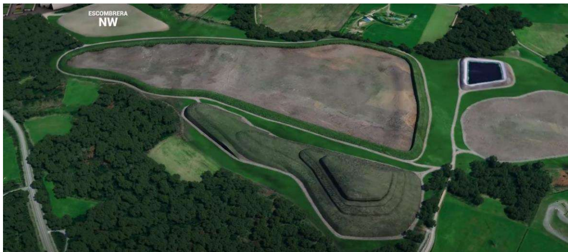
Figura 1.3.- Zona de las escombreras y el depósito. Superficies de ocupación preparadas para las escombreras NW y WE. Escombrera SW y depósito en operación.
