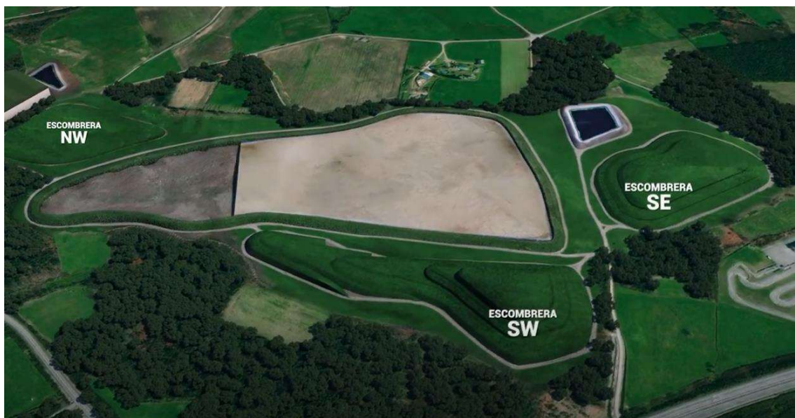
Figura 1.5.- Depósito en proceso de llenado.
