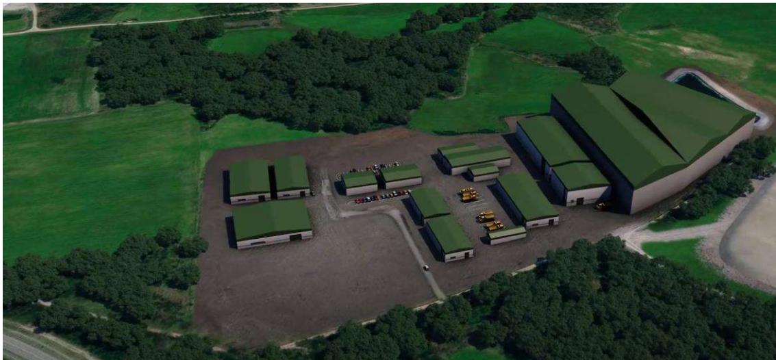
Figura 1.1.- Naves en la zona de instalaciones del proyecto.
